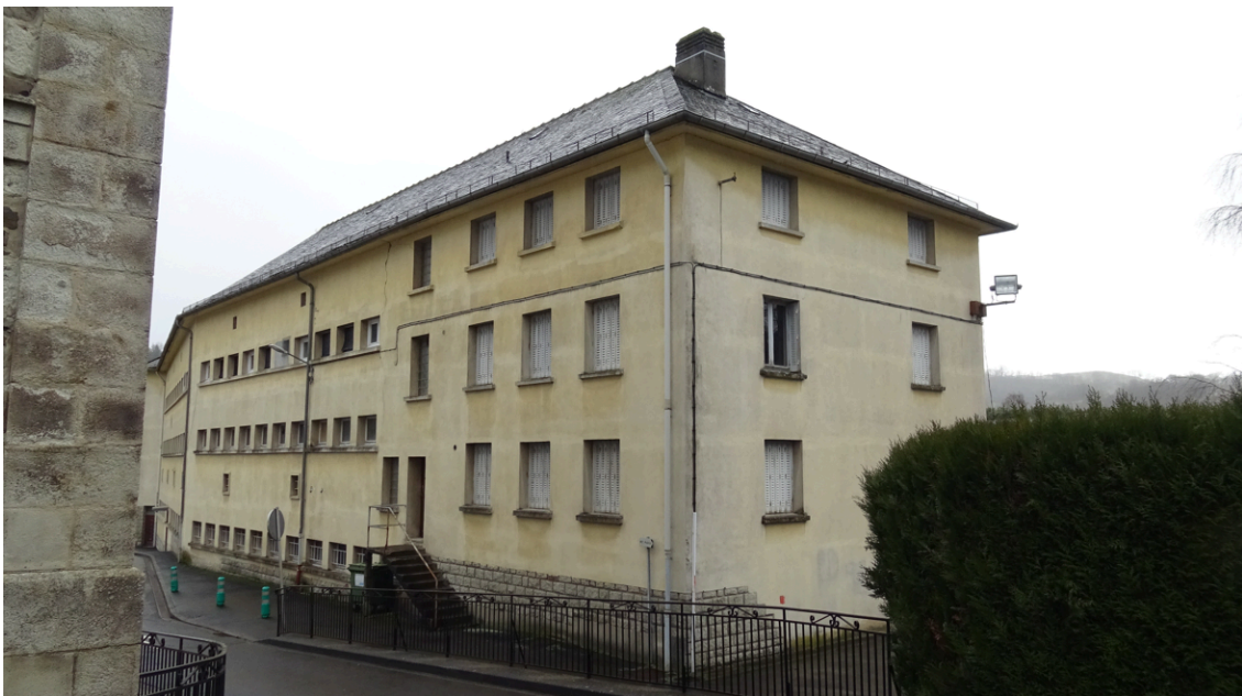
Ancienne aile de collège, futur tiers-lieu de Riom-ès-Montagne
