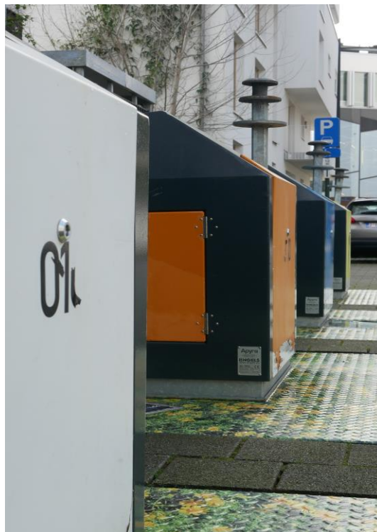
Système de tri avec poubelles conteneurs enterrés
